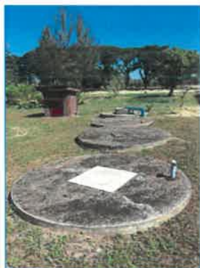
บ่อตกตะกอนจำนวน 3 บ่อและบ่อพักน้ำใส
