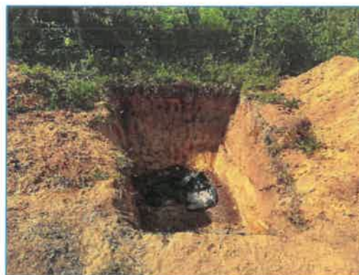
หลุมสำหรับรองรับกากไขมันจากห้องครัวก่อนนำไปทำเป็นปุ๋ยต้นไม้
