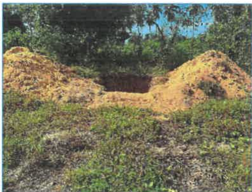
หลุมสำหรับรองรับกากไขมันจากห้องครัวก่อนนำไปทำเป็นปุ๋ยต้นไม้
